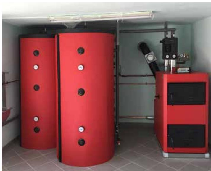
IBC Holzvergaser mit einem Hygiene-Kombi-Schichtenspeicher und einem Heizungspufferspeicher.
